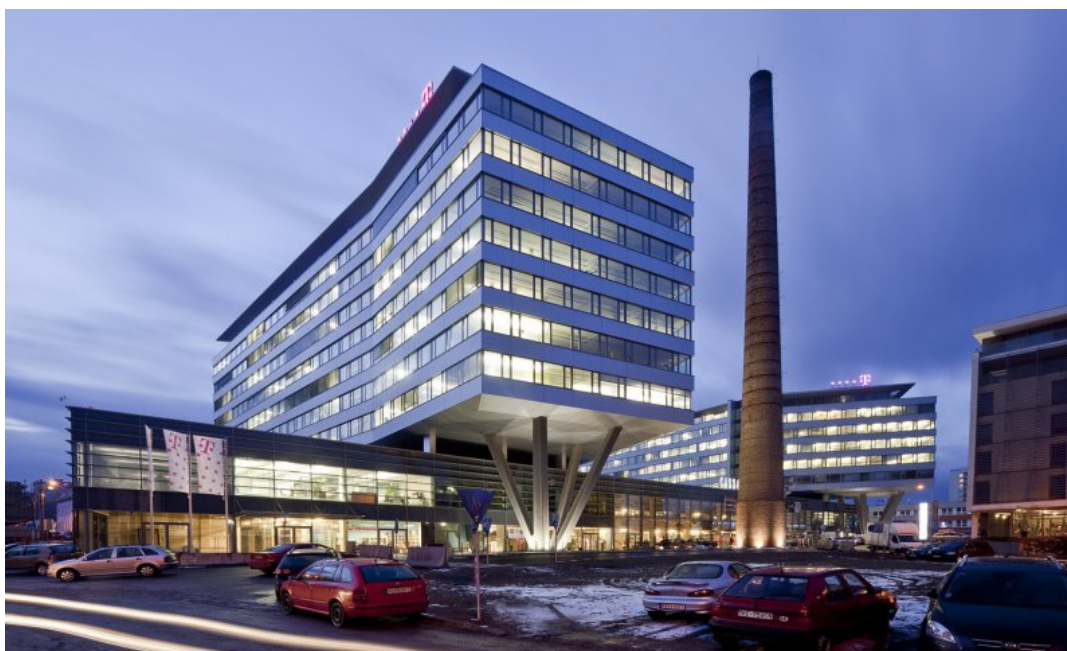
Konverzia areálu výroby v mestskej štruktúre na polyfunkčné centrum administratívy, služieb a bývania, Cassovar, Košice, zdroj: http://ce-za-ar.sk/?id=nominacie-obcianske-a-priemyselne-budovy (november 2013), autor fotografie: Ľubo Stacho
