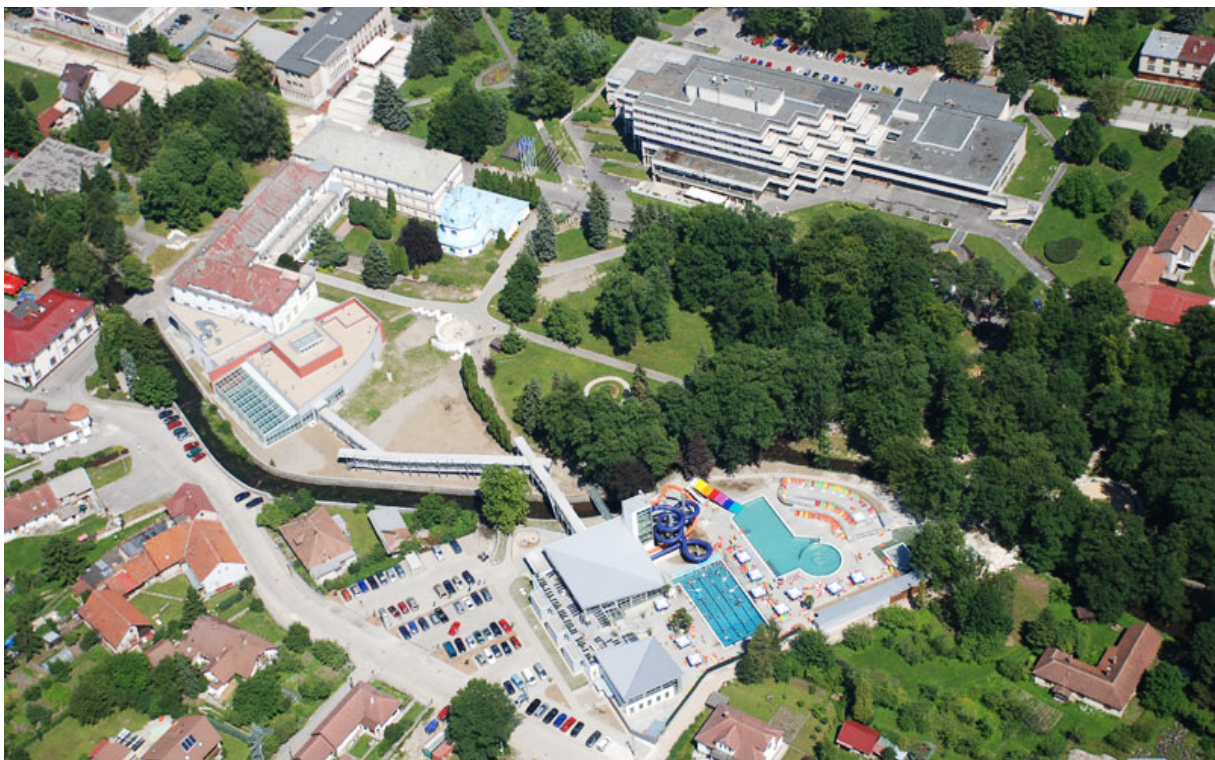
Komplex aquaparku a kúpeľných zariadení v centrálnom priestore mesta Turčianske Teplice 208
